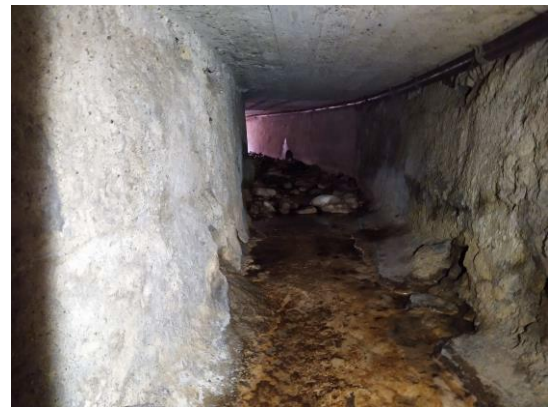
Abbildung 2: Bestehender Durchlass des Stoffelbach bei Querung Bernstrasse. Links und rechts sind die Straßensanabwassereinleitungen der Bernstrasse erkennbar, Blick gegen Fließrichtung
