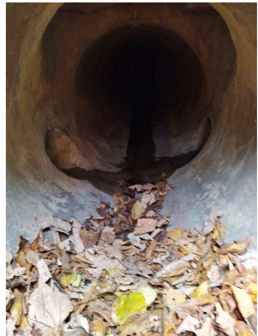
Abbildung 2: Bestehender Rohrdurchlass des Tobelbach bei Querung Bernstrasse. Links und rechts sind die Strassenabwassereinleitungen der Bernstrasse erkennbar, Blick in Fließrichtung
